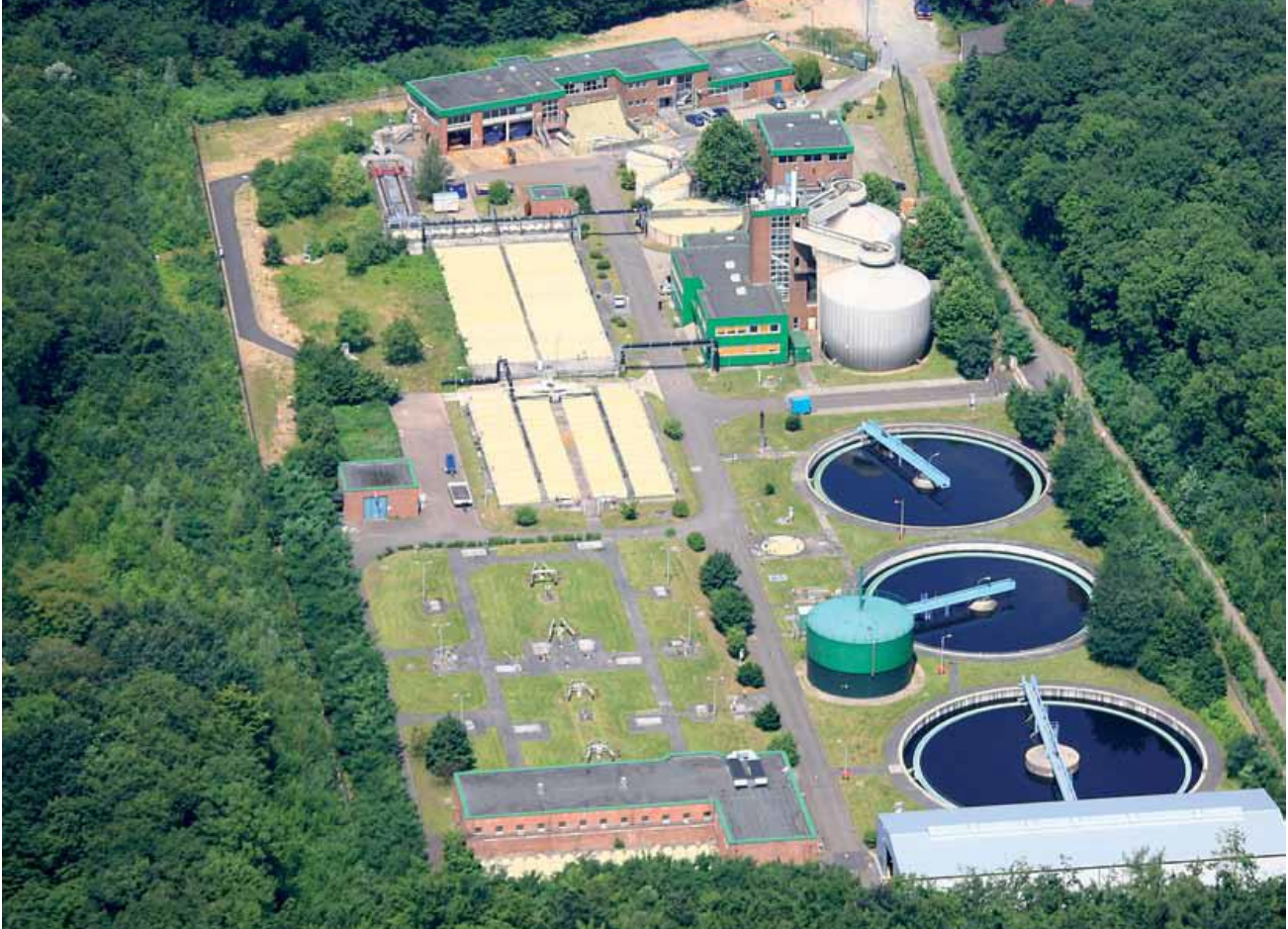
Bild 2: Luftbildaufnahme des Außenklärwerks Köln-Rodenkirchen (Foto von Herrn Hubert Harst)
