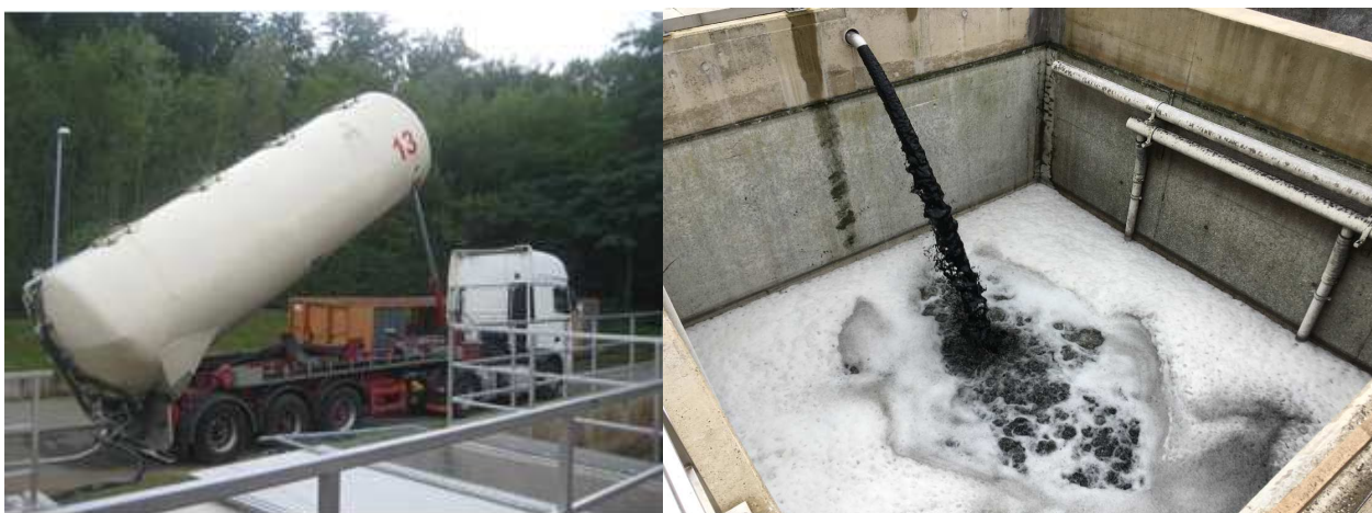
Bild 22: GAK-Filter bei Nasseinspülung der Aktivkohle mittels Silowagen
