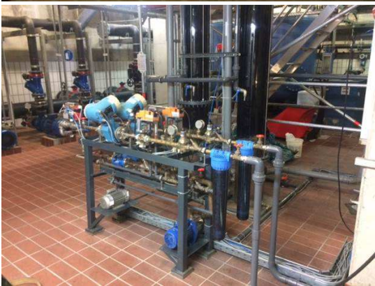
Bild 34: Halbtechnische Filtersäulen auf der KA Rodenkirchen (oben l.) und auf dem GWK Stammheim (oben r.) sowie Beschickungsmimik (unten l.) und Schaltschrank mit SPS (unten r.)
