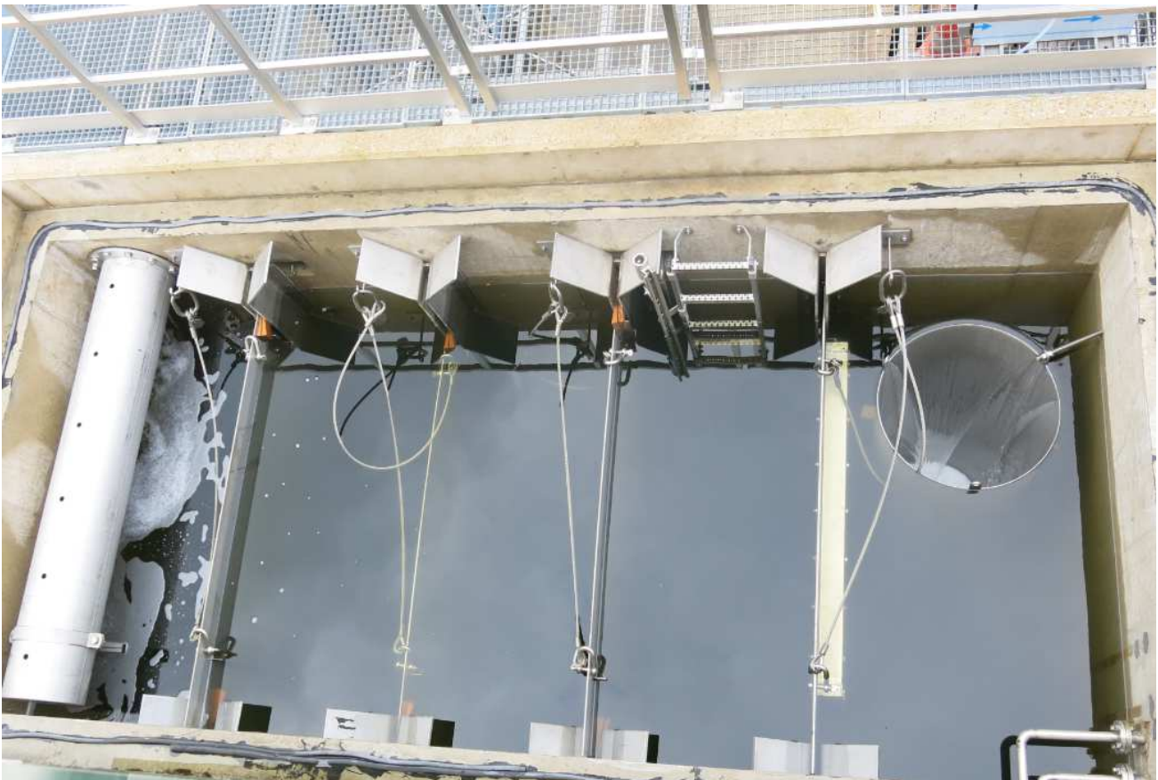
Bild 10: Blick in abwassergefüllten Ozonreaktor (bei abgenommenen Deckel und ohne Begasung)
