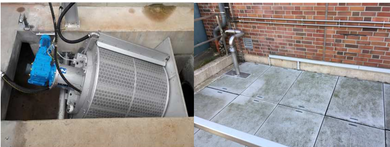
Bild 9: Rechenanlage im Zulaufgerinne der Filteranlage (links: Siebtrommel, rechts: Abdeckung)
