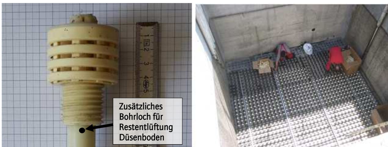
Bild 23: Filterdüsenkopf (links) und Einbau der Filterdüsen (rechts)
