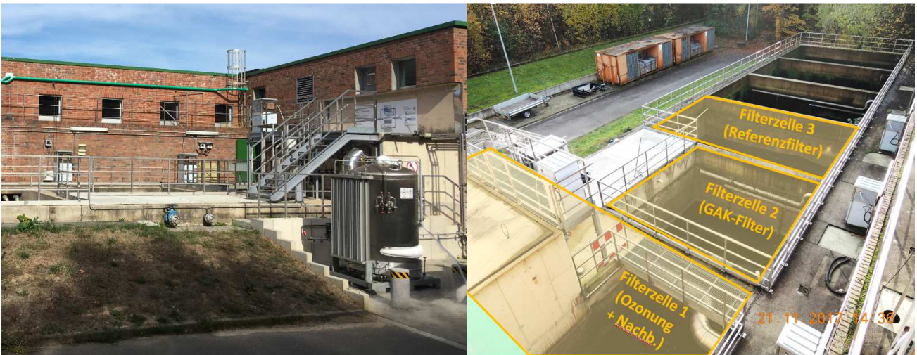
Bild 6: Umgebaute Filteranlage im Klärwerk Köln-Rodenkirchen (links: Seitenansicht, rechts: schräge Draufsicht)
