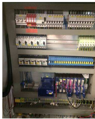
Bild 34: Halbtechnische Filtersäulen auf der KA Rodenkirchen (oben l.) und auf dem GWK Stammheim (oben r.) sowie Beschickungsmimik (unten l.) und Schaltschrank mit SPS (unten r.)
