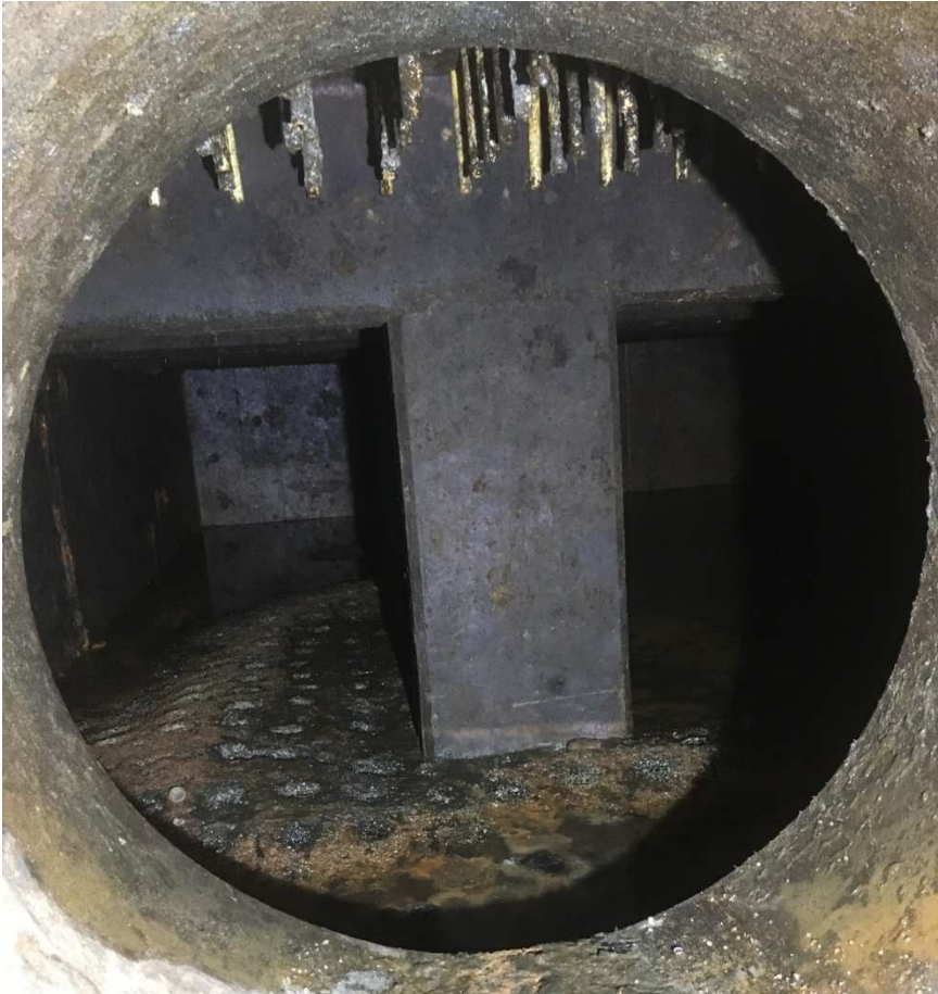
Bild 133: Kaum Ablagerung im Düsenbodenraum bei Revision im Januar 2020
