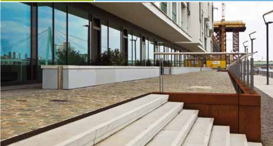
Foto links: Mitten durch den Rheinauhafen verläuft der neue Hochwasserschutz
