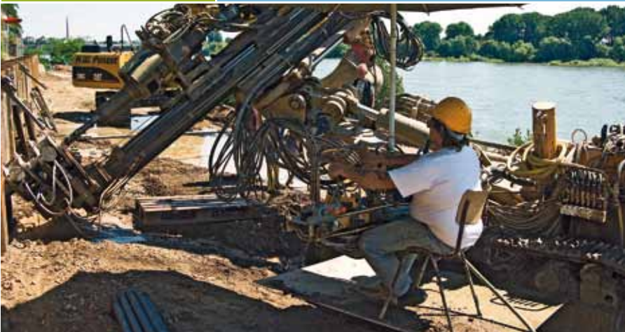
Foto links: Einbringen der Rückverankerung zur Stabilisierung der Spundwand
