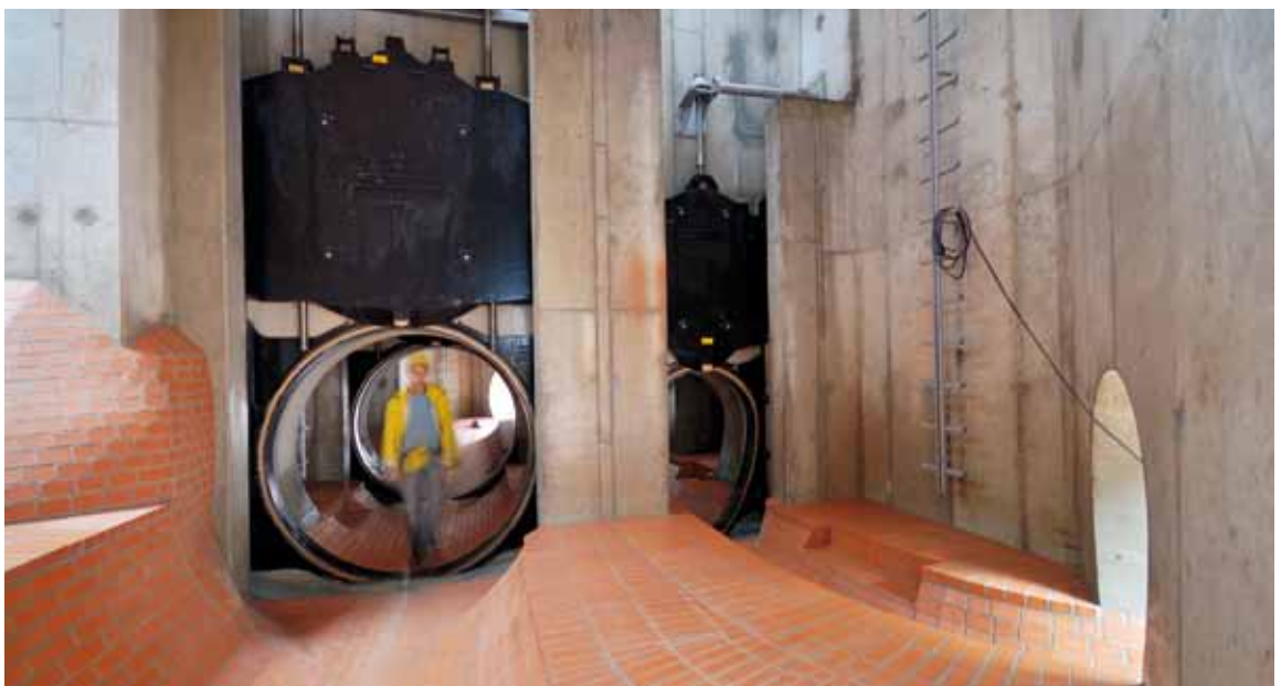
Einbau eines Hochwasserdoppelschieberschachtes in die Kanalisation in Rodenkirchen
