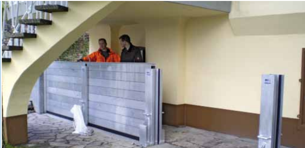
Fotos rechts: Baumaßnahmen zum Hochwasserschutz auf engstem Raum
