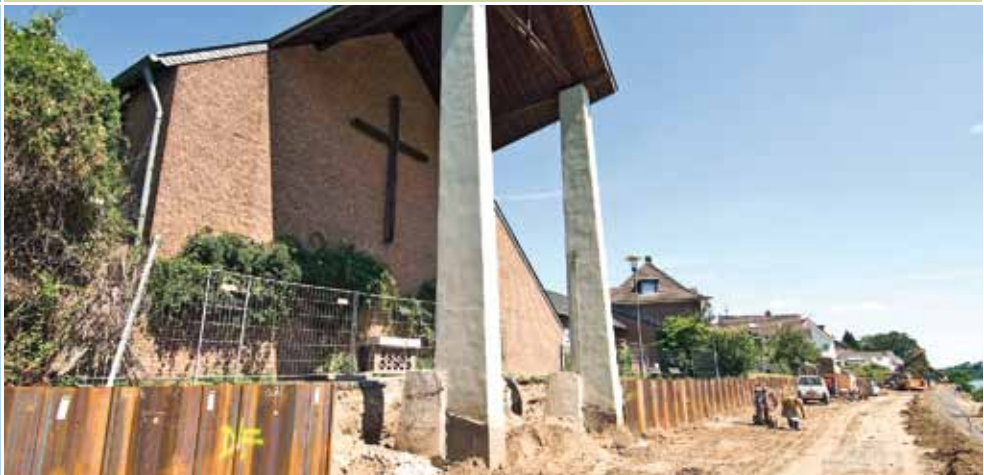
Fotos rechts: Bauarbeiten zum Hochwasserschutz in Köln-Sürth
