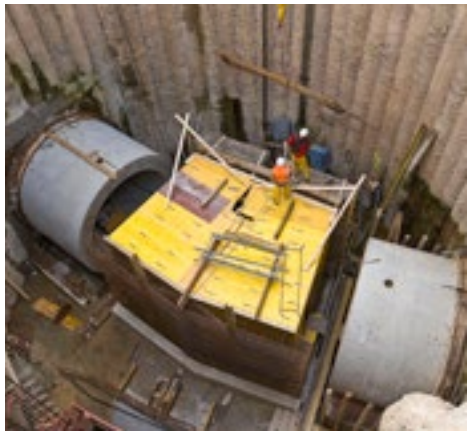
Schalungsarbeiten für Ortbetonbauwerk in Startbaugrube
