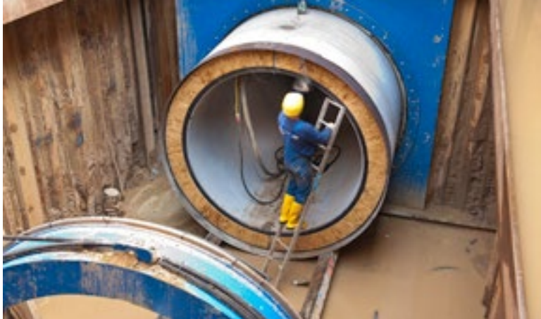
Startbaugrube bei einem unterirdischen Rohrvortrieb
