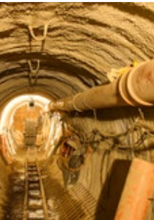
Ein bergmännisch hergestellter Stollen aus Spritzbeton
